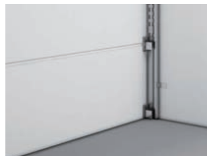
Fijación de anclajes interior
